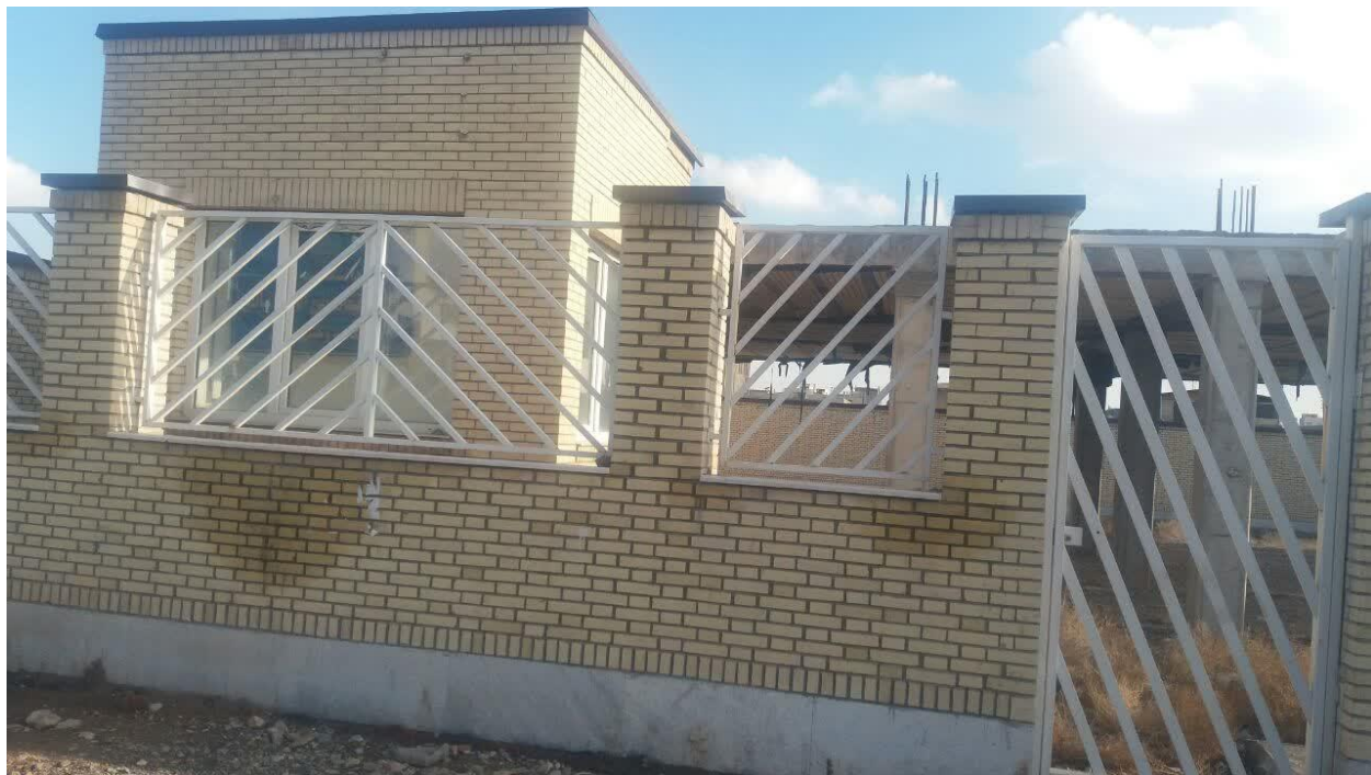
ساختمان جدید در دست احداث
