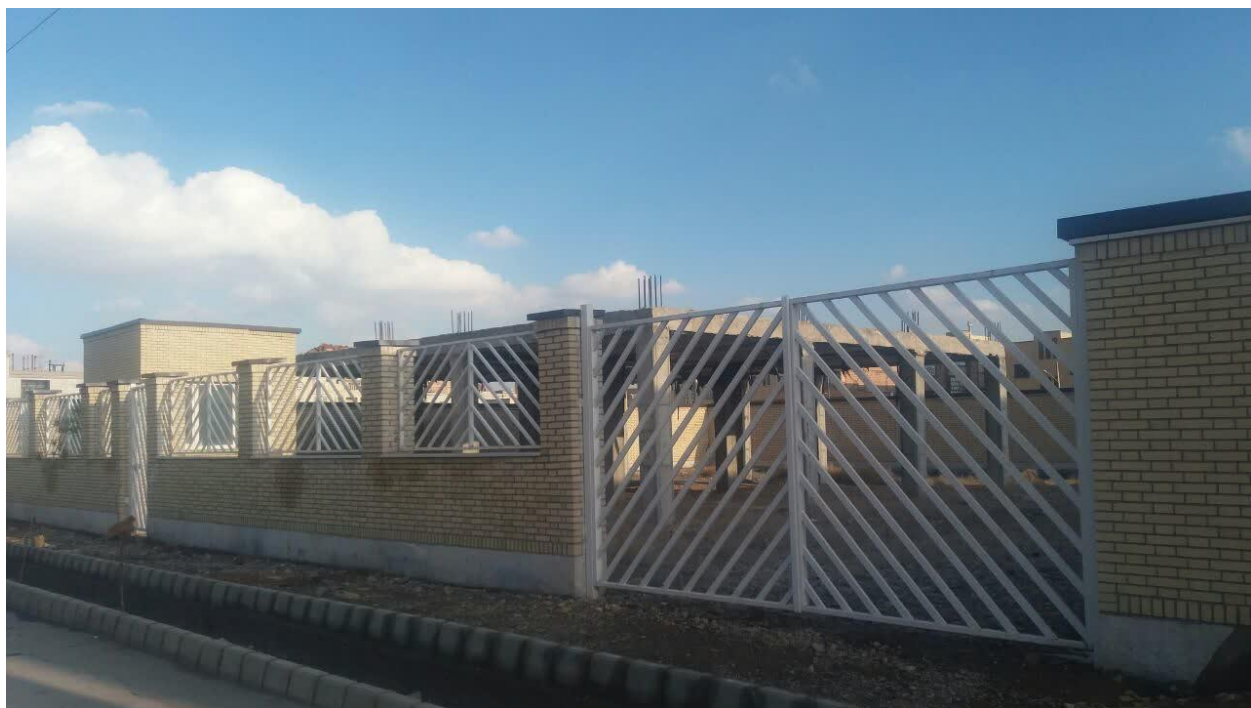
ساختمان جدید در دست احداث
